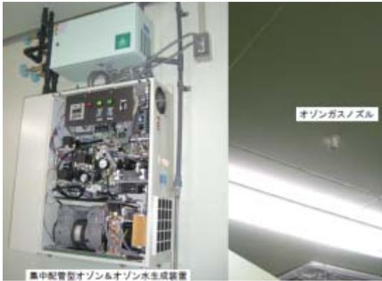
図9 ケーキ工場でのオゾンガス薫蒸システム
